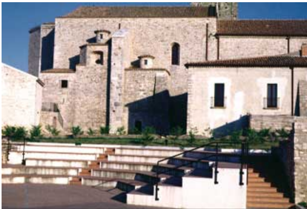
Le cappelle addossate al fianco nord-occidentale della cattedrale con, in primo piano, i giardini recentemente trasformati in centro sociale all'aperto. (Foto Emanuele Masiello, 1994)
