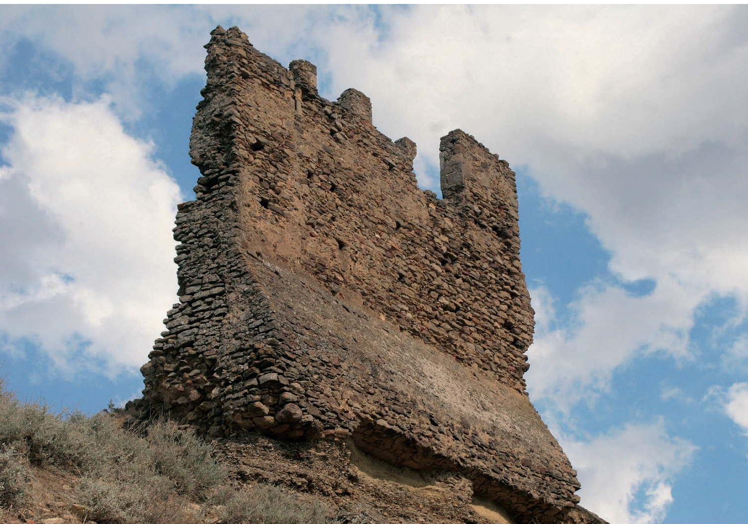
Figura 5 - Muro di cinta realizzato in diverse fasi (foto Lafranceschina)
