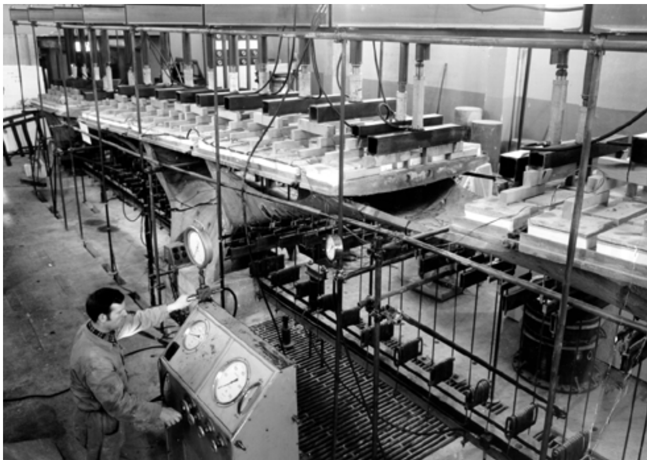
Prove sul modello in microcalcestruzzo (I.S.M.E.S.) (Foto: archivio Musmeci)
